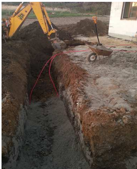
Fot. 1. Wykonanie dolnego źródła Źródło: Fot. R. Klimczak
