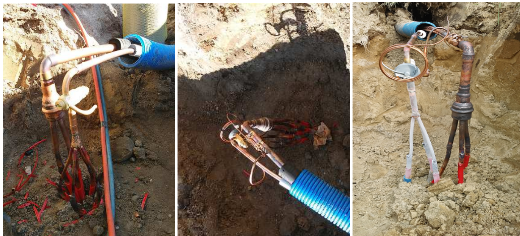
Fot. 2. Miejsce montażu zaworu rozprężnego
